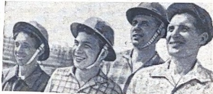
МОСКВА. Бригада Ивана Васильевича Шестака — одна из лучших в коллективе строителей треста «Мосстрой-7». Эта бригада строила в Москве жилые дома, магазины, административные здания. Сейчас бригада И. В. Шестака строит новые 9-этажные жилые дома в Нагатинно-Колхозной бригады соревнуется за выполнение семилетнего плана в III квартале 1965 года.
